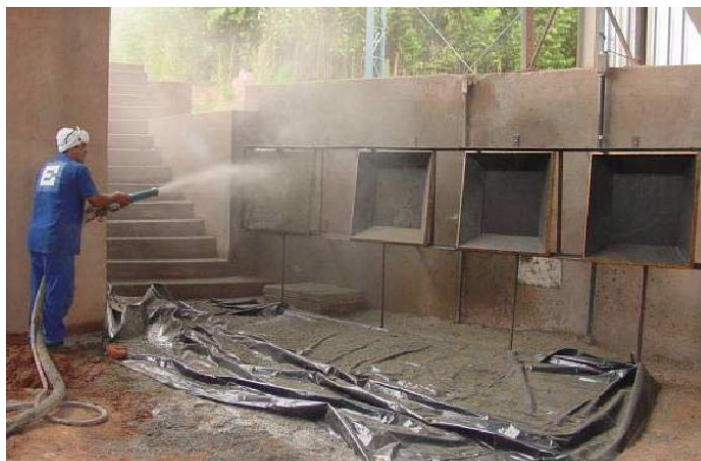
Figura 5-1 – Montagem utilizada para a moldagem das placas.
